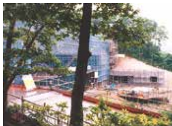
①文学館の建設工事の様子(1997年8月)。
